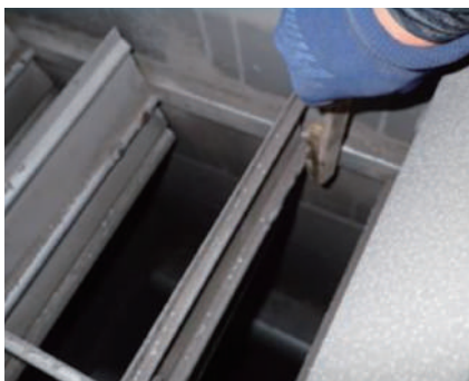
軸受部の汚れ、錆をブラッシングにて除去
